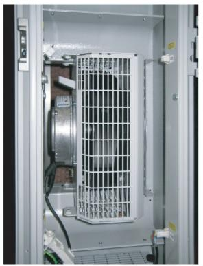
Fig. 41: Rotated fan module in fan tray
